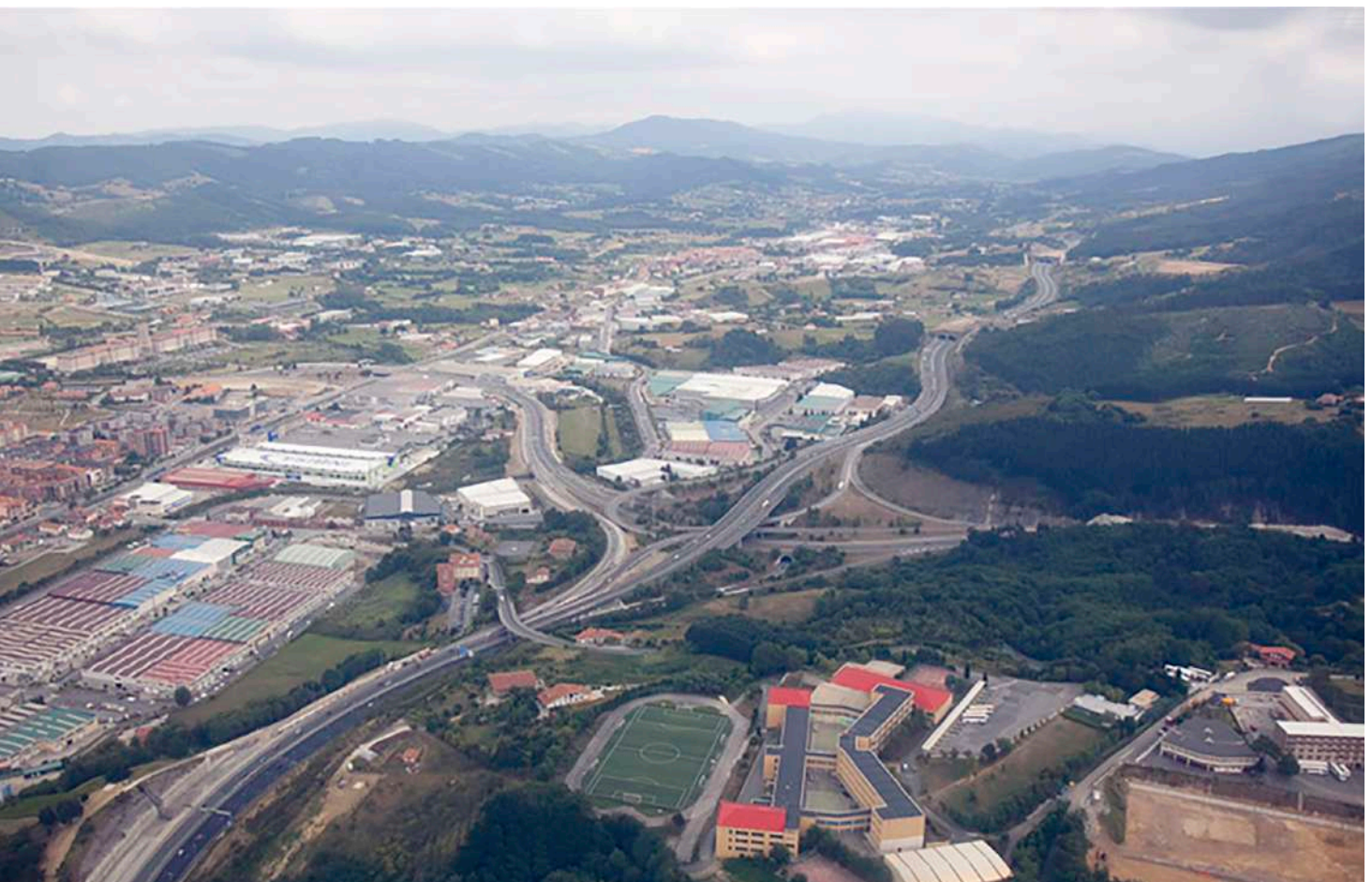
Borja Gómez, Corredor del Txorierri completo y su enlace con la BI-631 https://bilbaoenconstruccion.com/
